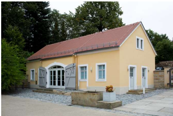
vor und in der Remise
